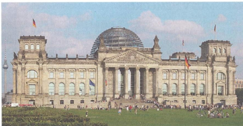
Budova Říšského sněmu (Reichstagu) v Berlíně. Skleněná kupole na střeše pochází ovšem až z doby po druhé světové válce.
